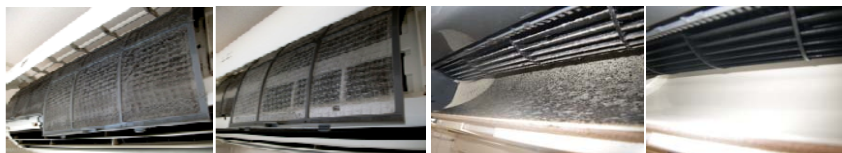
フィルター部分(洗浄前) ⇒ フィルター部分(洗浄後) 噴出し部分(洗浄前) ⇒ 噴出し部分(洗浄後)
